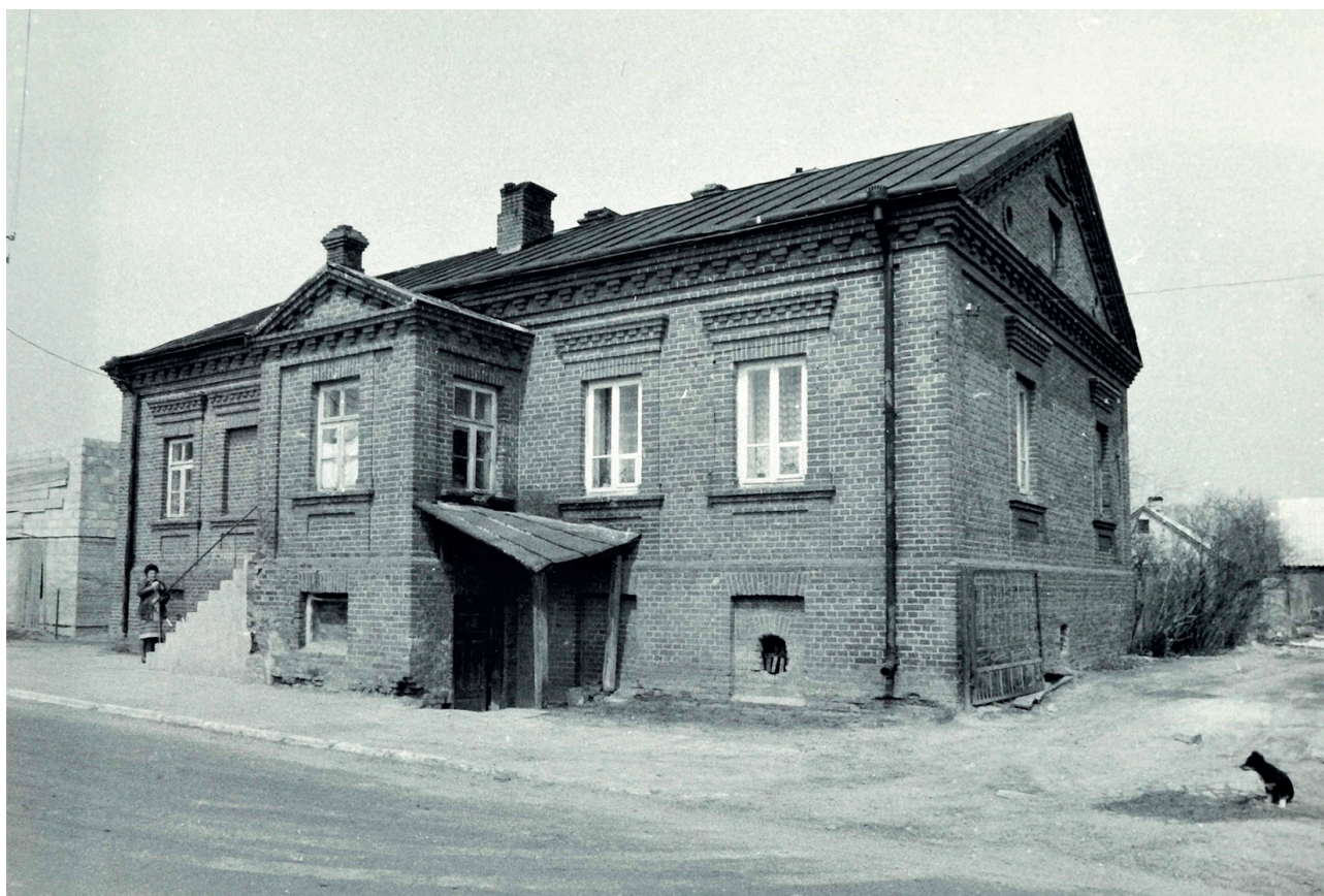
Pawłów. Budynek, w którym do 1969 r. mieścił się Posterunek Milicji Obywatelskiej (stan z 1987 r.)
