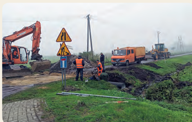
Prace na ul. Pastownie w Pawłowie
