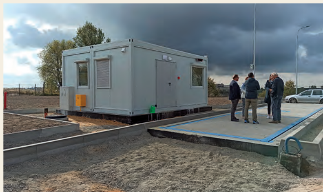
Budowa PSZOK w Pawłowie
