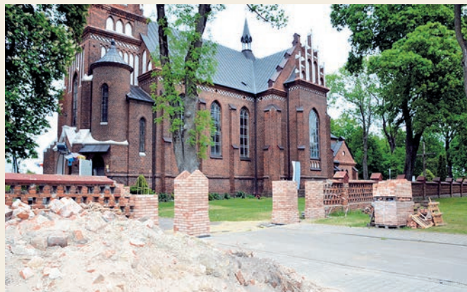
Budowa nowej bramy wjazdowej. Fot. D. Karwat
